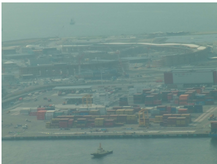
解体中の関西万博会場
